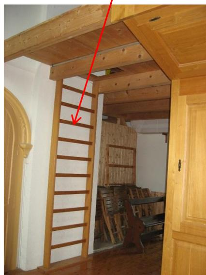
Sécurité de la partie supérieure non garantie (aucun garde-corps)
